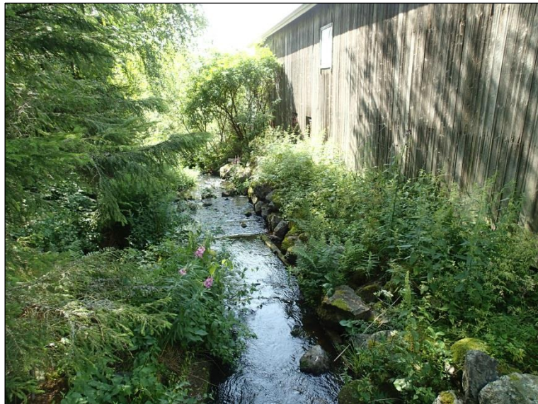
Vanha myllyrakennus sivu-uoman pohjoisrannalla. Länteen.
