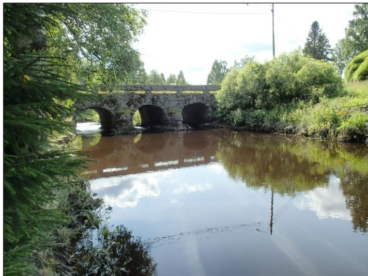
Pääuomaa sillan pohjoispuolella, lounaaseen.
